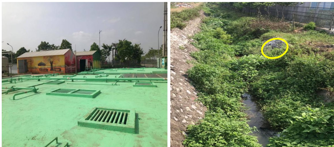
Hình 1.4. HTXLNT của nhà máy hiện hữu, công suất 950m 3 /ng.đ và điểm xả thải
