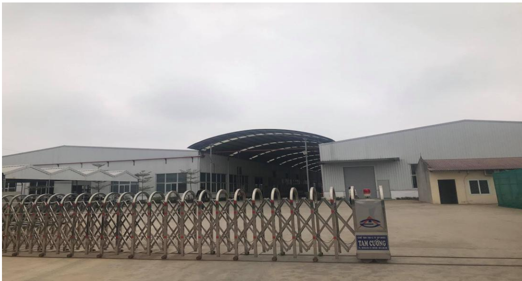
Hình 1.2. Hiện trạng khu vực thực hiện dự án
